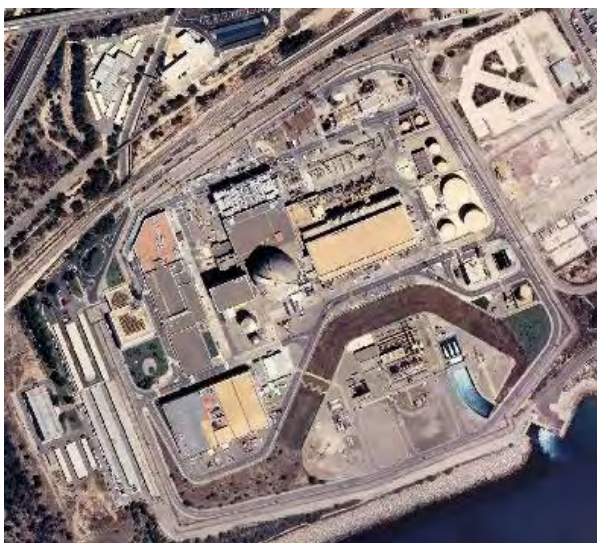
Central Nuclear de Vandellòs II . Font: ICC
