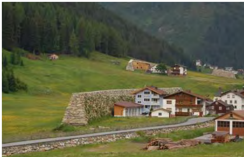
Obra de defensa passiva (mur de contenció) a Galtür (Àustria). Font: DGPC
