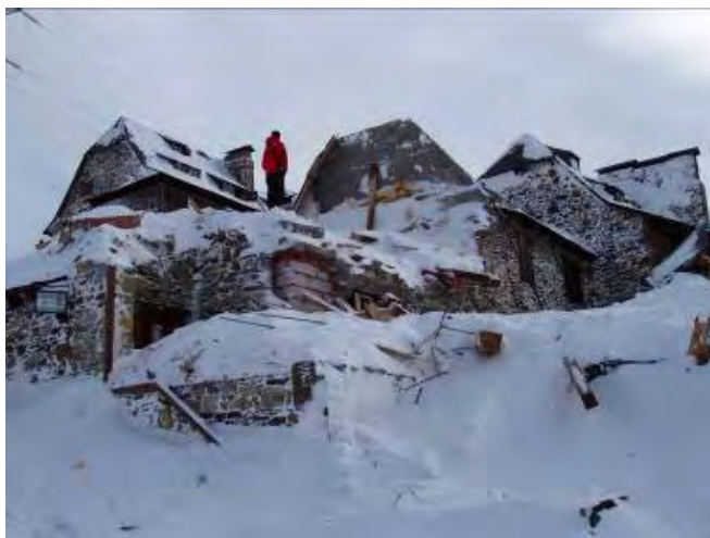
Habitatges afectats per allau a la Vall d'Aran. Font: Institut Geològic de Catalunya (IGC).
