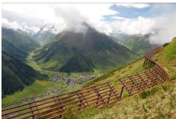
Obres de defensa activa (rastell) a Galtür (Àustria). Font: DGPC
