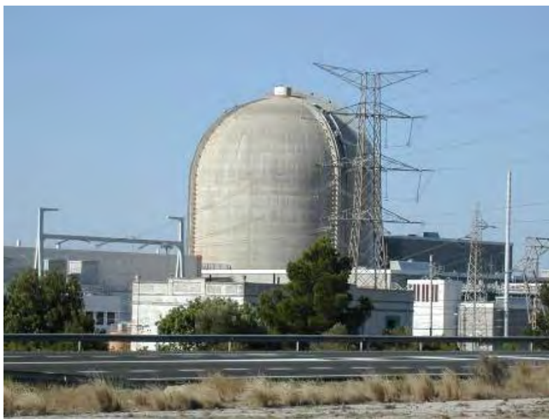
Central Nuclear de Vandellòs II. Font: Direcció General de Protecció Civil.
